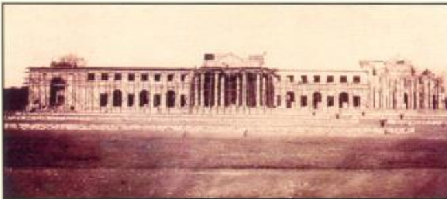
वन अनुसंधान संस्थान मुख्य भवन का निर्माणाधीन पूर्वी ब्लॉक
