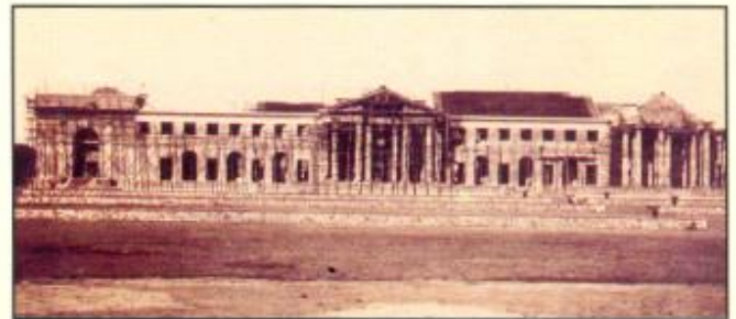
वन अनुसंधान संस्थान मुख्य भवन का निर्माणाधीन पश्चिमी ब्लॉक
